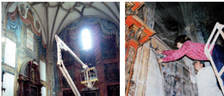
Figs. 29-30. Desmontaje de los cuadros.
