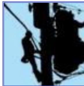
Cuando el trabajo se realiza en un solo conductor de una línea aérea de alta tensión no es necesario el cortocircuito, aunque sí la puesta a tierra, de la zona de trabajo, si se cumple que:
