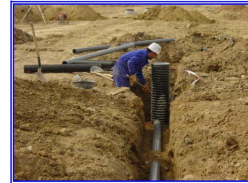
Una vez realizada la excavación de la zanja y comprobada la estabilidad de los taludes de la misma se procederá a la colocación de tubería, previa extensión de la capa de hormigón o arena que sirva de base a la misma. La colocación de esta tubería será realizada por un equipo de 3-4 operarios especializados en la ejecución de este tipo de trabajo, los cuales serán ayudados cuando sea necesario por la labor de una máquina (mixta o retroexcavadora dotada de eslingas).
