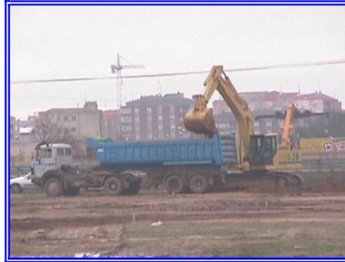
Para la realización de estos trabajos se utiliza fundamentalmente maquinaria de movimiento de tierras tal como retroexcavadoras, camiones, etc...Se considera también la presencia de un peón en labores de apoyo.
